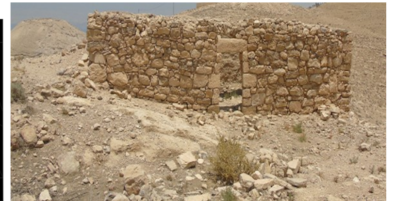
شكل رقم (7) يوضح الواجهة الأمامية لبيت تيم خليف القعايدة. المصدر: الباحث.
